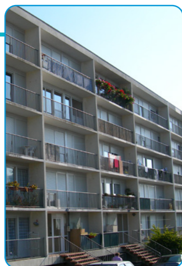
Le bâtiment G avant
