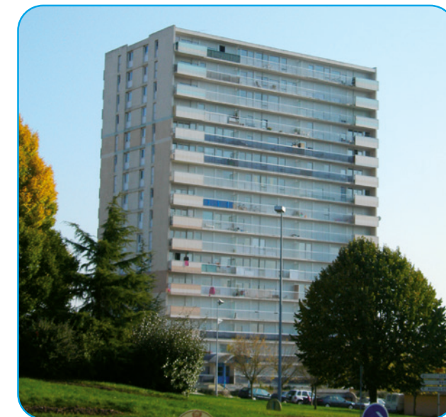
La tour T6 avant les travaux
