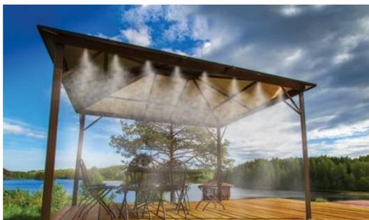
Pour rappel la pergola sera composée de 2 modules. Quatre rampes parallèles de brumisateurs haute pression seront fixées sous le plafond des 2 modules constituant la pergola. Soit 4x 6ml.
