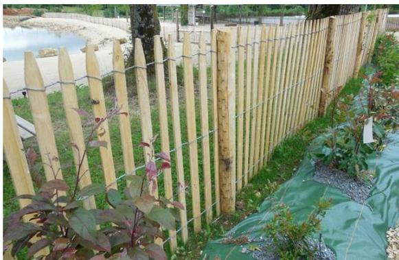
Il s'agit de clôtures type clôture « GANIVELLE » constituée d'échalas de châtaignier dont les lattes de bois sont sciées (calibrées en 45 mm de large et 13 d'épaisseur, appointées) et dont l'assemblage réalisé avec du fil galvanisé doublé de 1,8 mm en torsions équilibrées.
