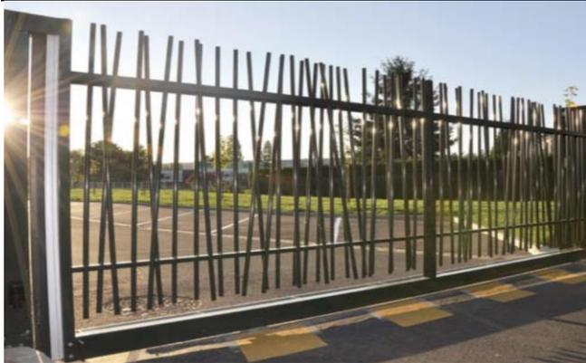
Il s'agit d'un portail roulant motorisé et barreaudé grise de type OOBAMBOO de chez NORMACLO ou similaire.
